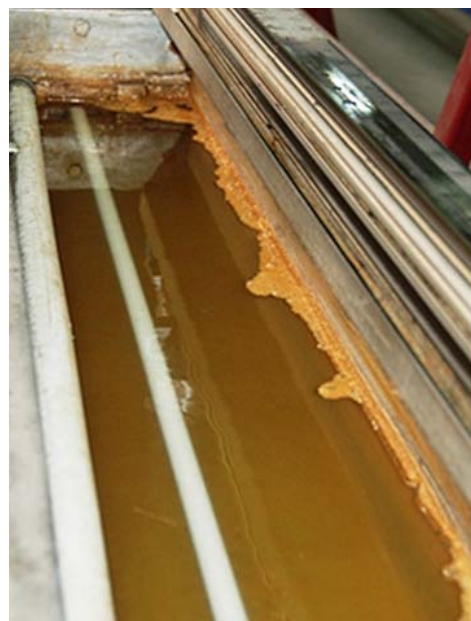
Typischer Anblick in der Kühlstrecke eines Extruders vor Einsatz der Wasserbehandlung.
