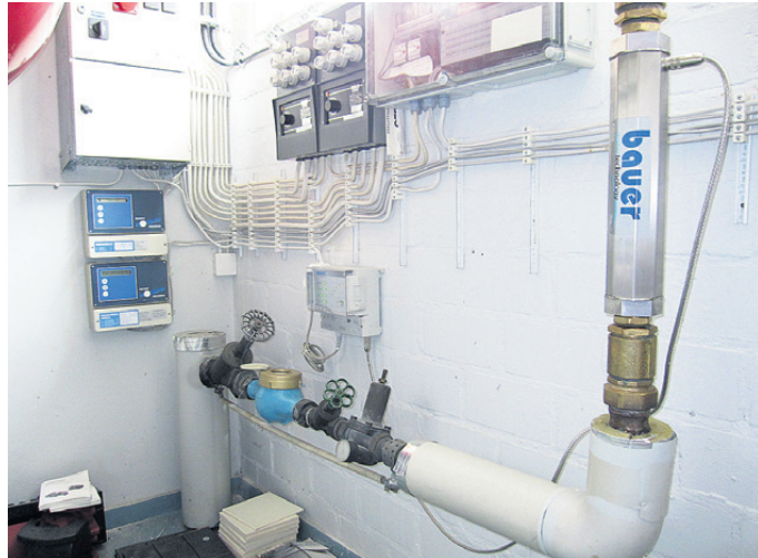
Bauer-vedenkäsittelyjärjestelmä asennettuna käyttövesijärjestelmään.
