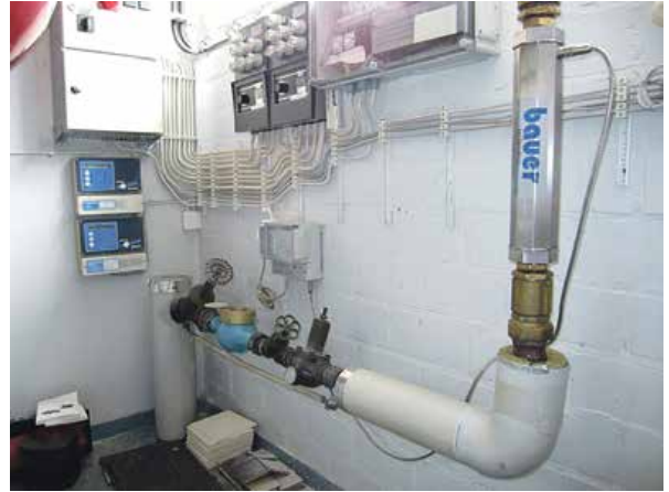
Käyttövesiasennus vesimittarin jälkeen.
