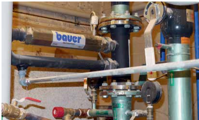
Kustaankadulla Bauerin vedenkäsittelylaitteisto asennetuna lämmitysverkostoon.
