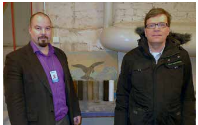
Bauerin Timo Tollander ja Kustaankatu 6:n isännöitsijä Petteri Soini kertovat lämpöverkon toimivan entistä paremmin. Taustalla näkyvät vaihdettuja vedenkäsittelylaitteiston suodattimia.
